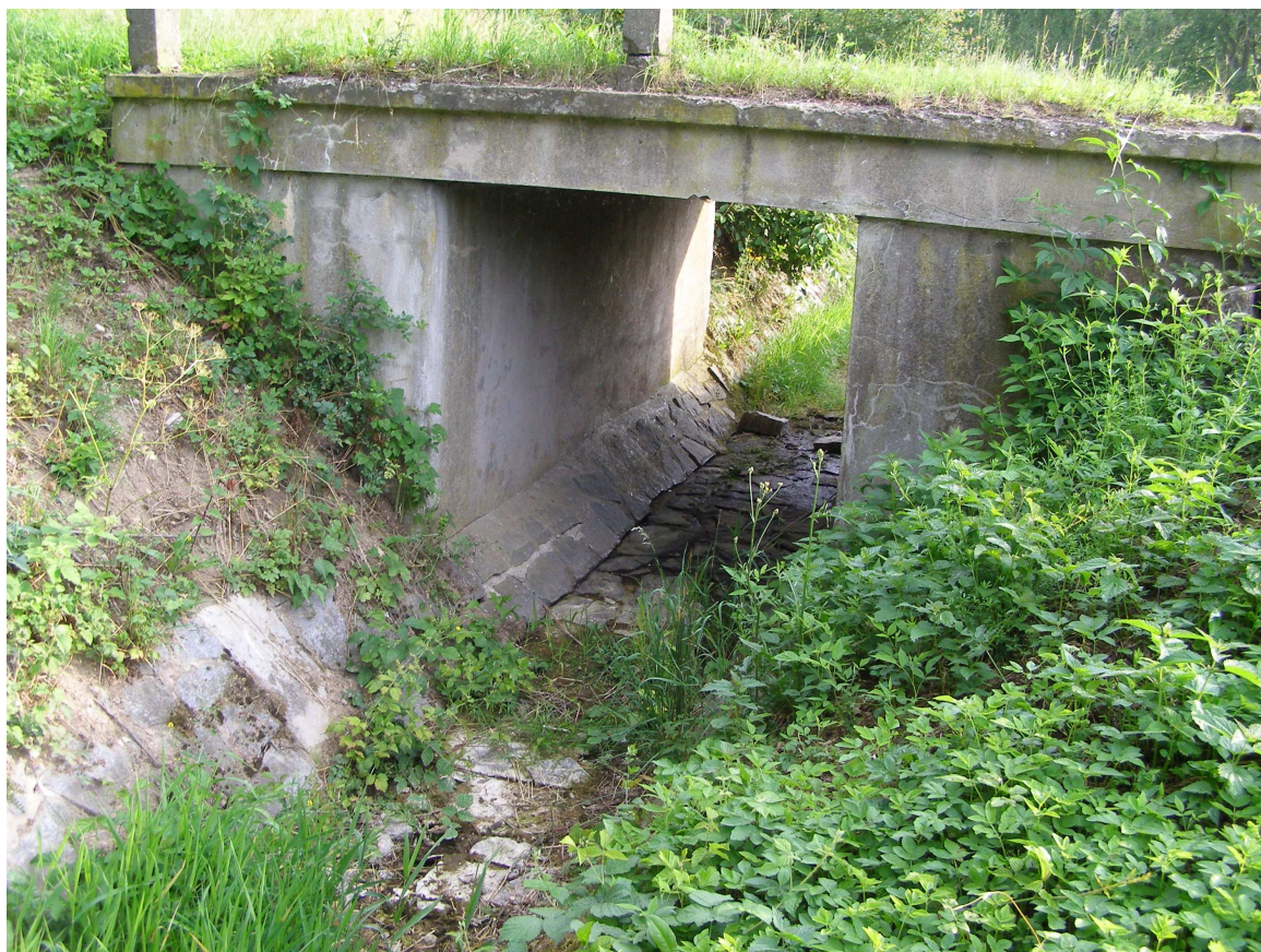
3 – Deskový propustek – odtok z bezpečnostního přelivu
